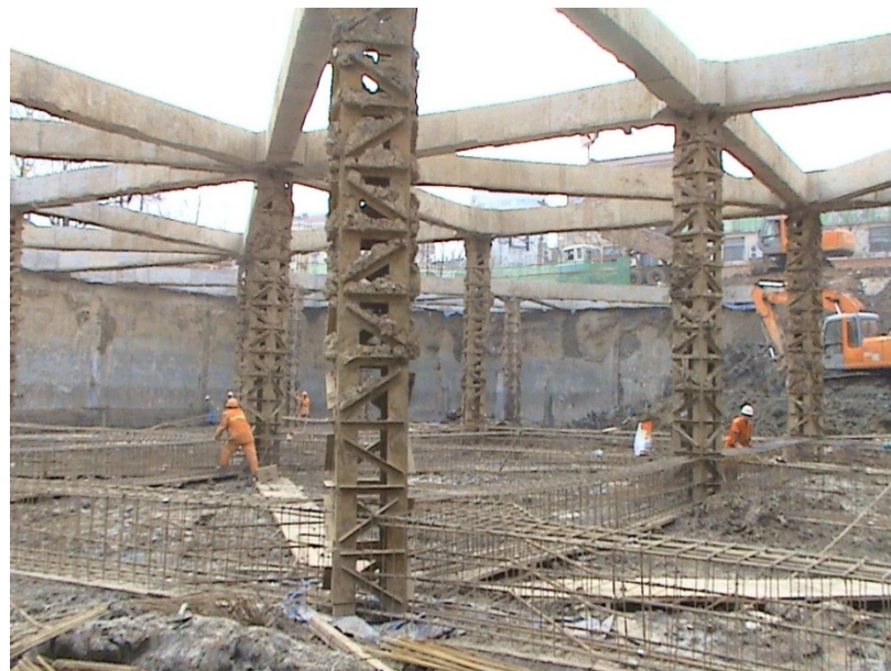
钢筋混凝土支撑
