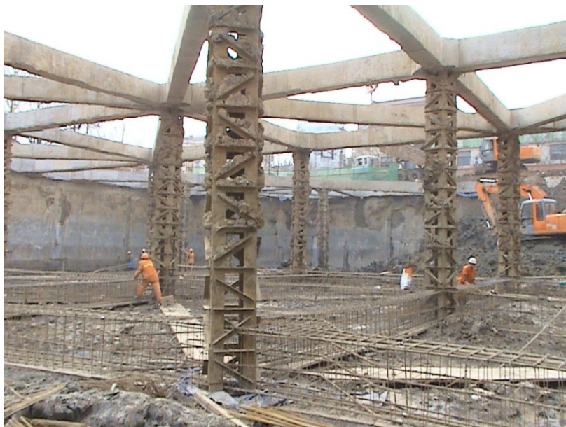
钢筋混凝土支撑
